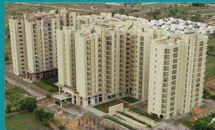
Vedanta, Jaipur | 269 Flats
